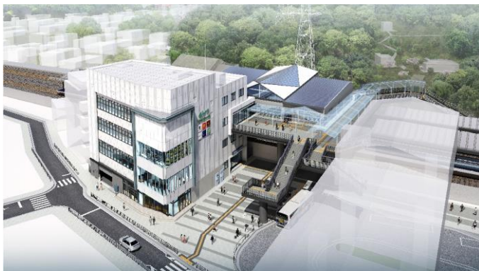
駅周辺全体外観
